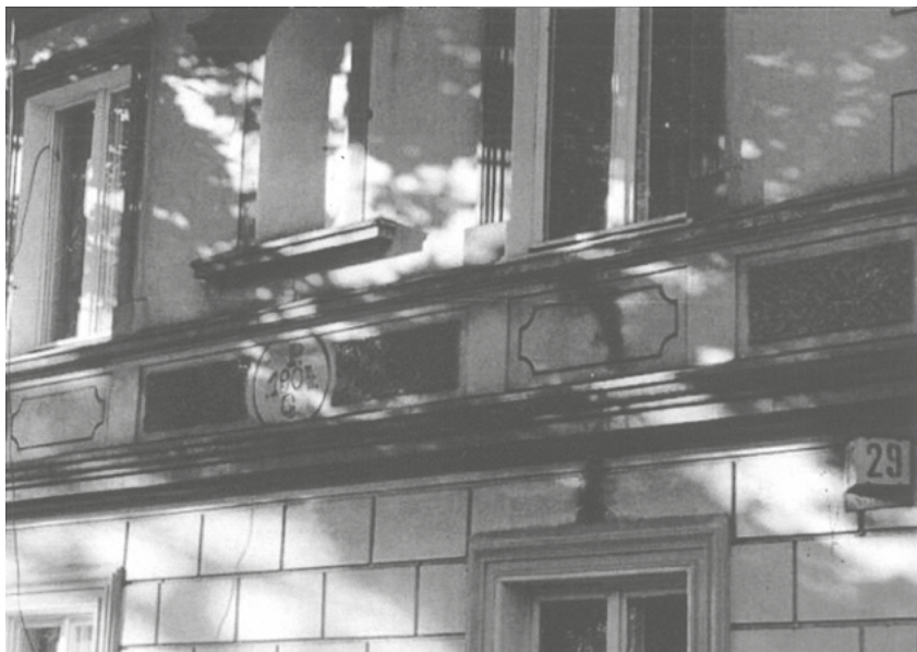
Budynek przy ulicy Średniej 29, wybudowany w roku 1904 przez Piotra Gąsiorowskiego
